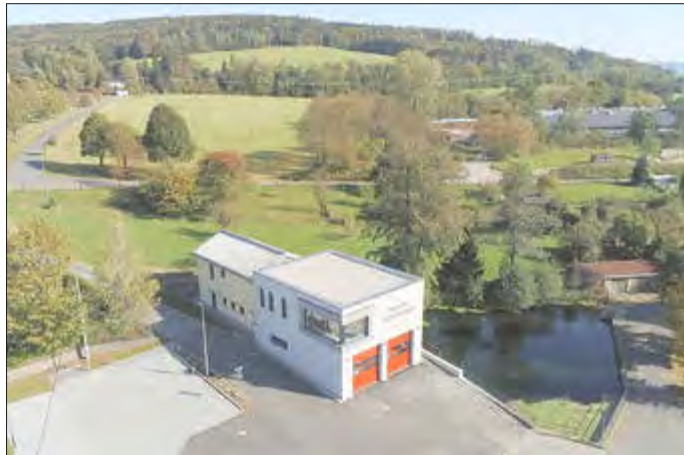
Blick auf das Krumhermsdorfer Feuerwehrgerätehaus mit Erweiterungsbau, Foto: E. Bartsch
