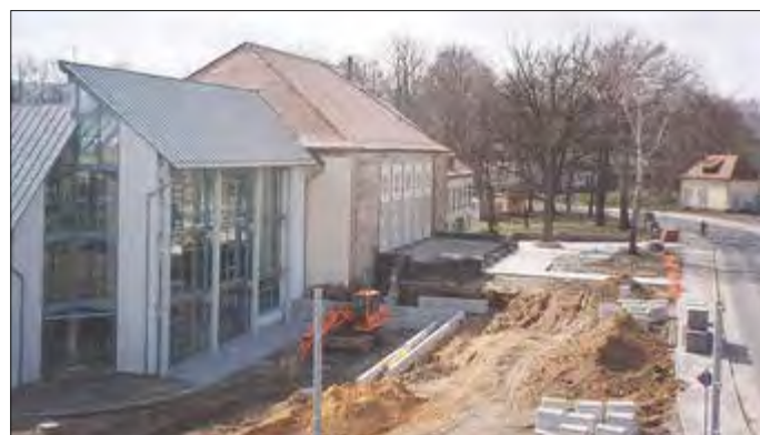
Bau des Eingangsbereiches 1995
