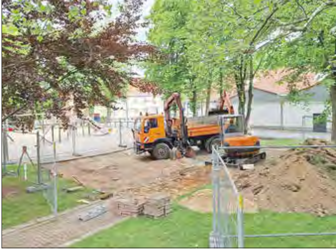
Erneuerung des Untergrunds im Mai 2025
