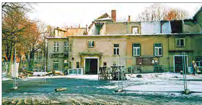
Abrissarbeiten im November 1991, Foto: Manfred Herzog
