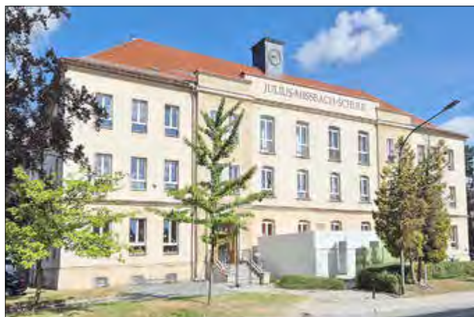
Sanitärcontainer vor der Grundschule
