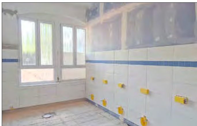
Sanitärtrakt während der Bauphase
