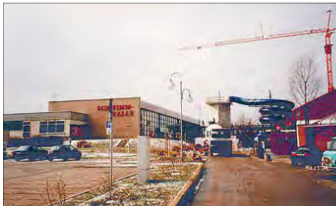
Während des Baus, links im Bild die alte Schwimmhalle
