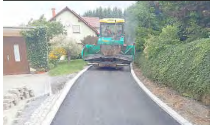
Asphalteinbau am Schwarzbachweg im Ortsteil Krumhermsdorf
