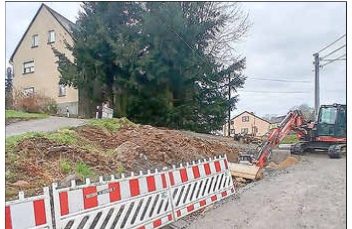
Vorbereitende Profilierungsarbeiten für den Asphaltbau
