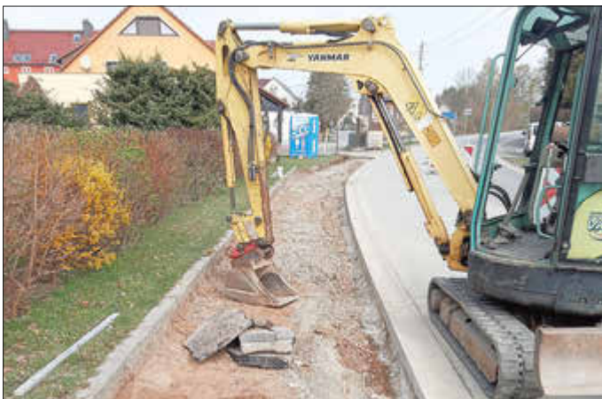
Bauarbeiten für neuen Gehweg im Ortsteil Oberottendorf, nach der Bushaltestelle Richtung Oberdorf
