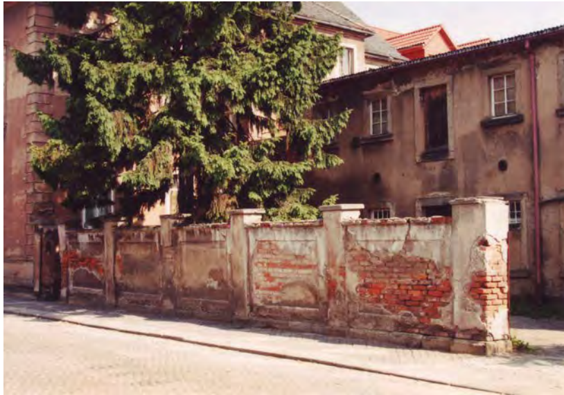
Struvestraße / Ecke Dr.-Wilhelm-Külz-Straße
