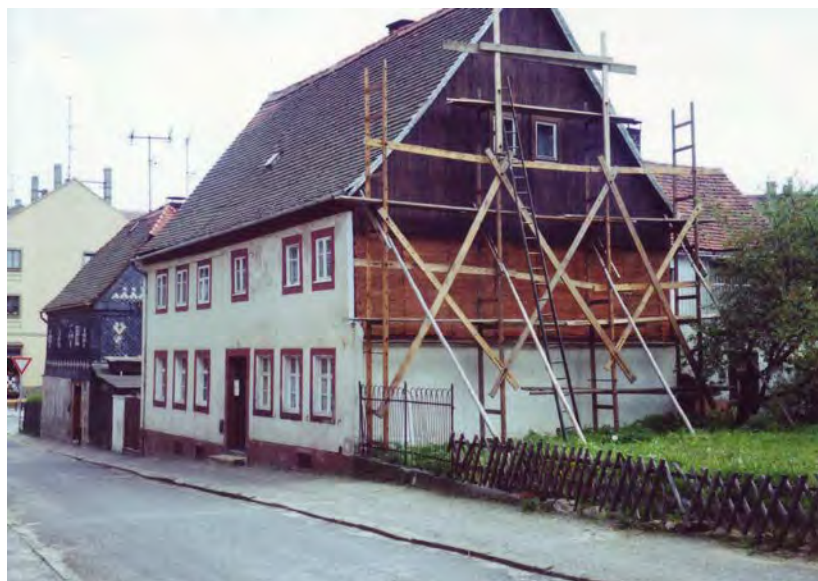
Polnzer Gasse – Blick in Richtung Osten
